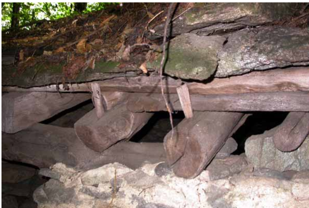
Particolare della struttura di un tetto in lose
